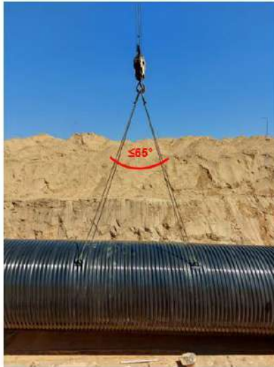
2 pav. Rezervuaro stropavimas
